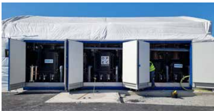
Figur 1: Fullskalig SAFF40 reningsanläggning installerad vid Tveta Återvinning.
